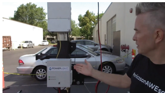
شکل ۱. جعبه توزیع PowerLight در ایستگاه پایه نسل پنجم
